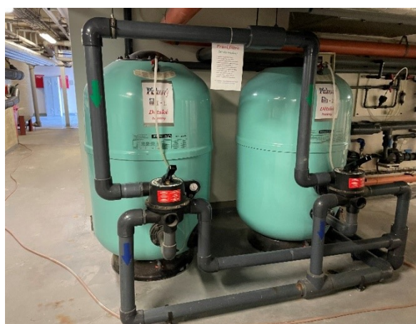
Obrázek 4: Pískové filtry okruhů D.
