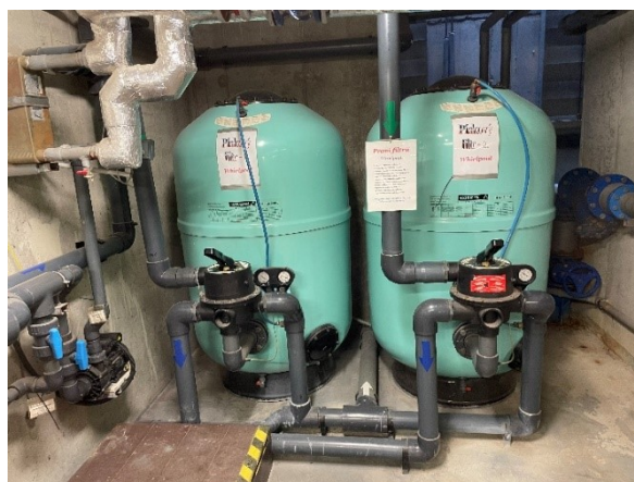
Obrázek 2: Pískové filtry okruhů B.
