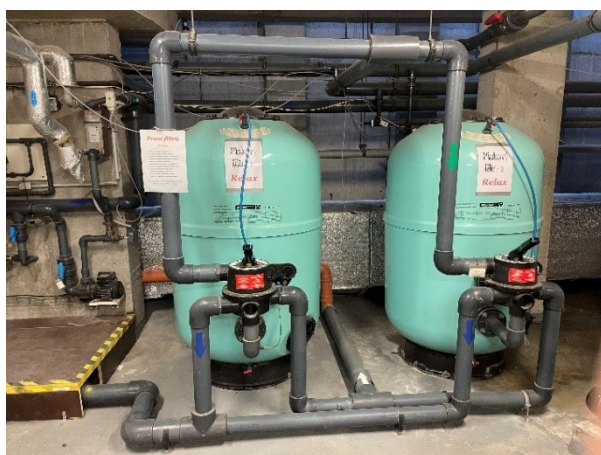
Obrázek 3: Pískové filtry okruhů C.
