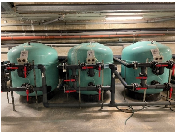
Obrázek 1: Pískové filtry okruhů A.
